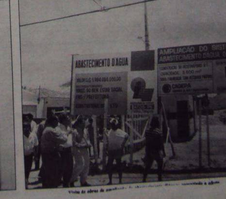
Visita às obras de ampliação do sistema de abastecimento de água em Patos
