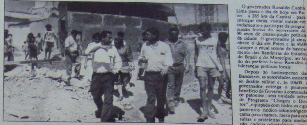
Em junho passado, o governador já fazia visita de inspeção à obra da adutora da Açude Capoeira
