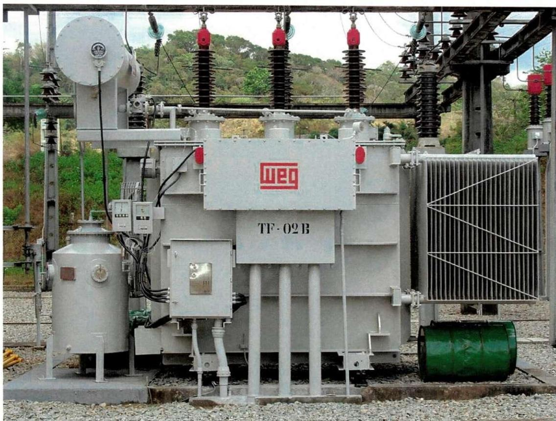
Figura 2 – Transformador da subestação com o respirador de óleo
