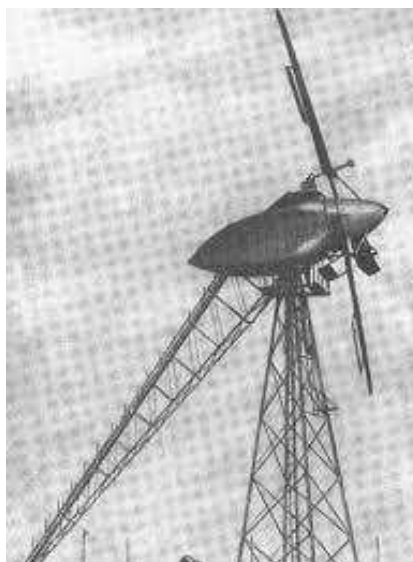
Figura 11: Turbina eólica Balaclava, 1931.
