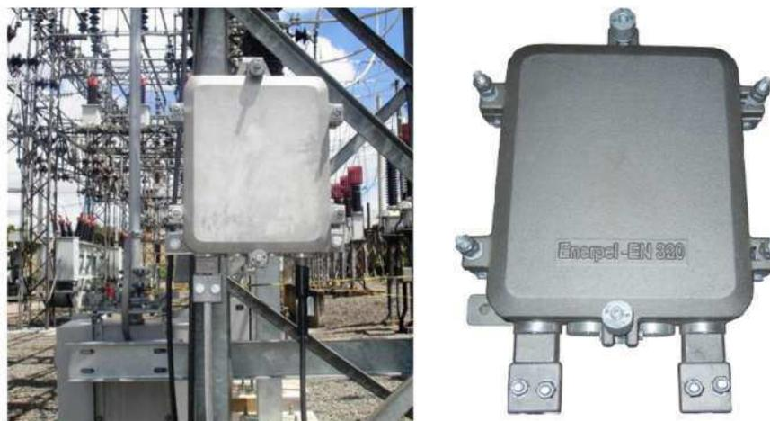
Figura 2.4 – Caixa de emenda OPGW com capacidade de 24 a 96 fibras da marca Enerpel.
