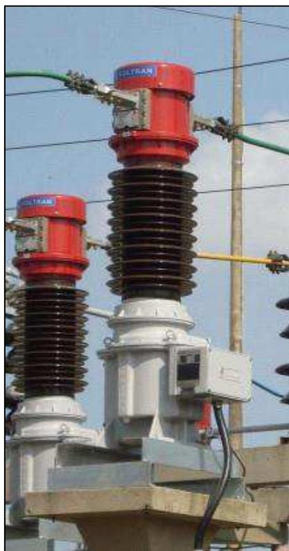
Figura 39. Transformador de corrente de alta tensão – óleo – SOC 72[18].
