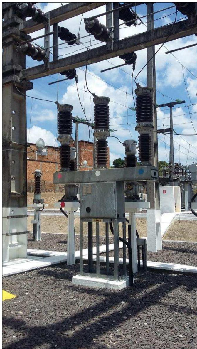
Figura 12. Disjuntor SF6 Merlin Gerin 69 kV – SE Estância – Sulgipe (Fonte: Elaborada pelo autor).
