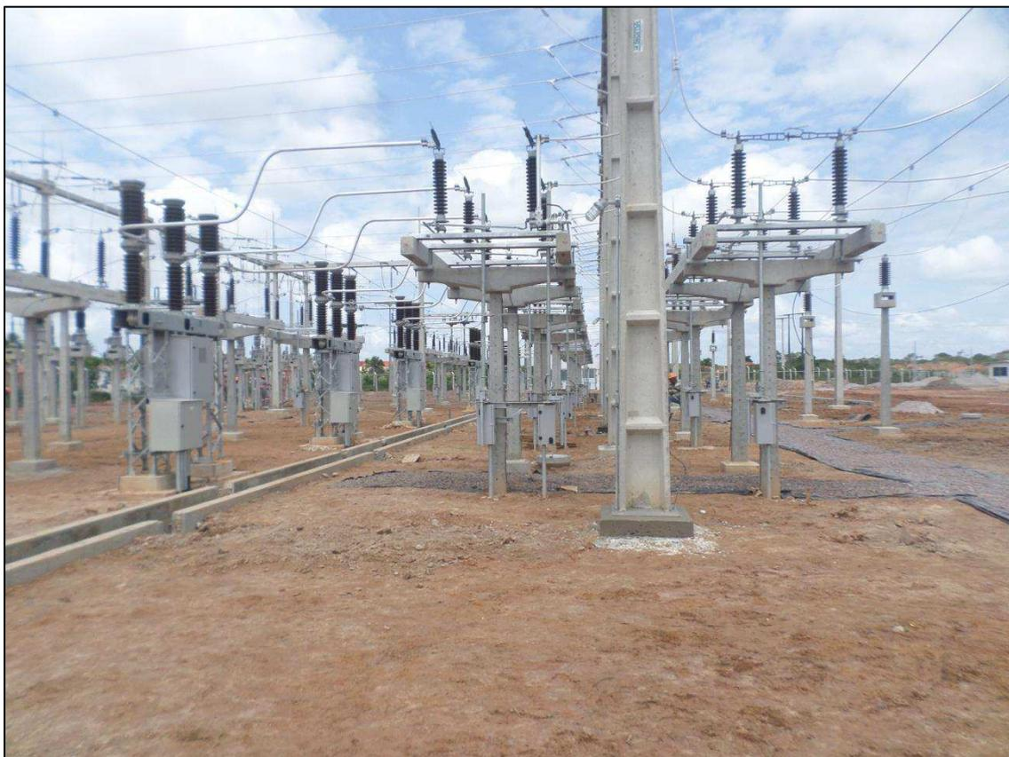
Figura 24. Chave seccionadora Delmar - Subestação Seccionadora Jorge Prado Leite. (Fonte: Elaborada pelo autor)
