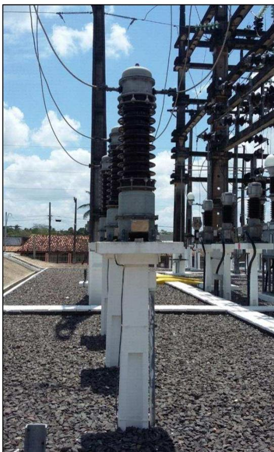
Figura 13. Transformador de corrente IMG Magrini Galileo – SE Estância – Sulgipe. (Fonte: Elaborada pelo autor)
