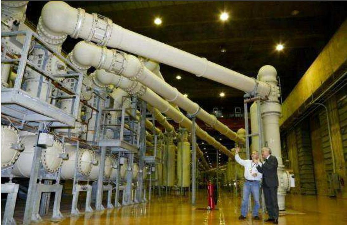
Figura 5. Subestação blindada a gás – Itaipu[11].
