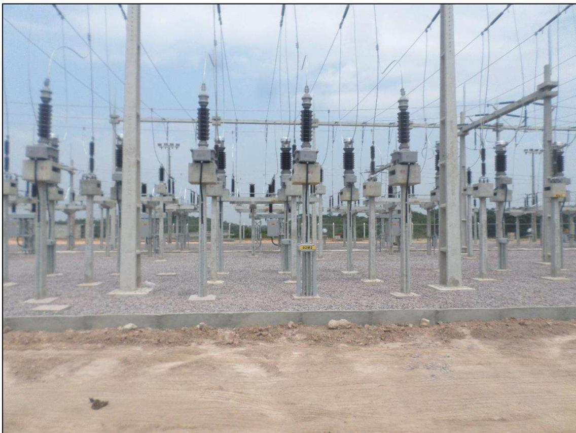
Figura 23. Transformador de Potencial Soltran - Subestação Seccionadora Jorge Prado Leite. (Fonte: Elaborada pelo autor)
