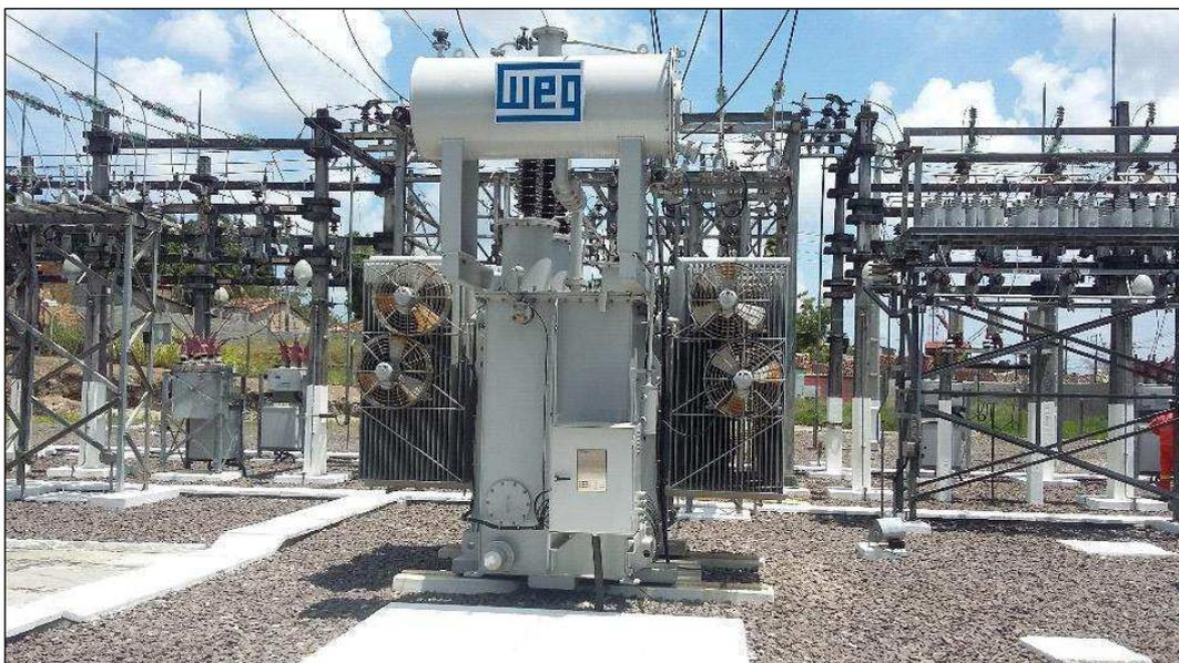
Figura 2. Subestação abaixadora – Estância/SE – Sulgipe (Fonte: Elaborada pelo autor).
