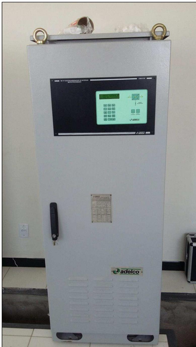
Figura 44. Retificador carregador de baterias microprocessado ADELCO CBM-9100 (Fonte: Elaborada pelo autor).
