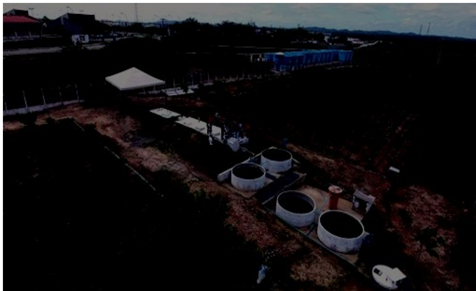
Figura 1 - Área experimental e estação de tratamento de esgoto doméstico da sede do Instituto Nacional do Semiárido INSA, Campina Grande, Paraíba.
