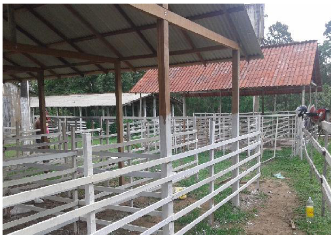
Figura 1. Galpão com telha de fibrocimento e PVC
