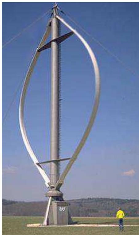
Figura 12: Turbina de eixo vertical tipo Darrieus
