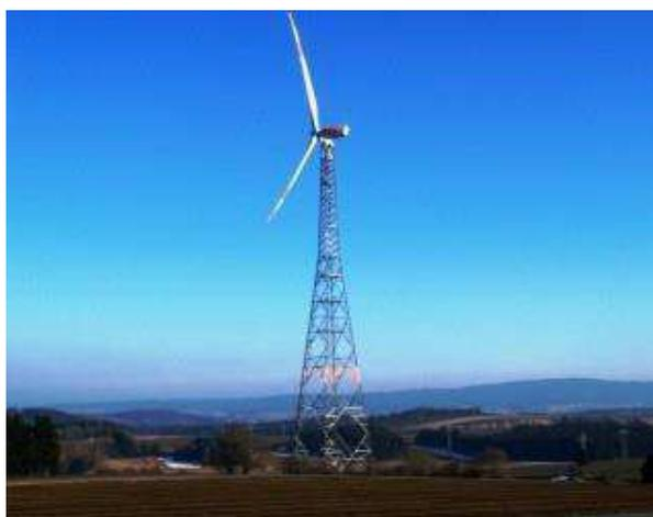
FIGURA 50 - TORRE ENTRELAÇADA DE UM AEROGERADOR
