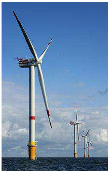
Figura 11 – Rotor de eixo horizontal com tripás. <5>.
