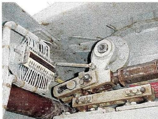
Figura 3.15. Chave auxiliar e mecanismo após limpeza.
