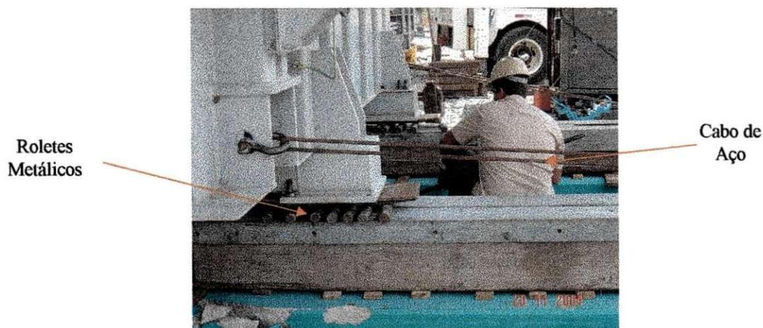
Figura 3.30. Técnica de “Carga Pesada”
