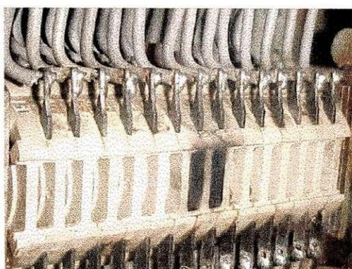
Figura 3.12. Chave auxiliar com sinais de carbonização
