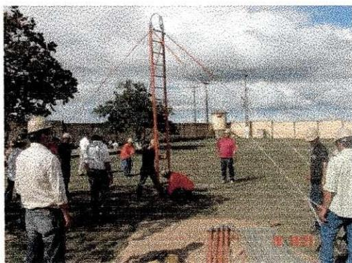
Figura 2.4. Escada isolante estaiada
