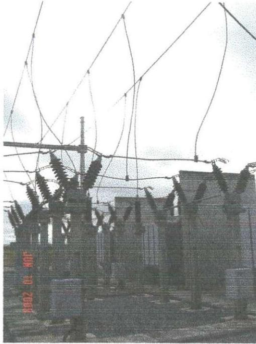
**Figura 06 – Chave Seccionadora**
