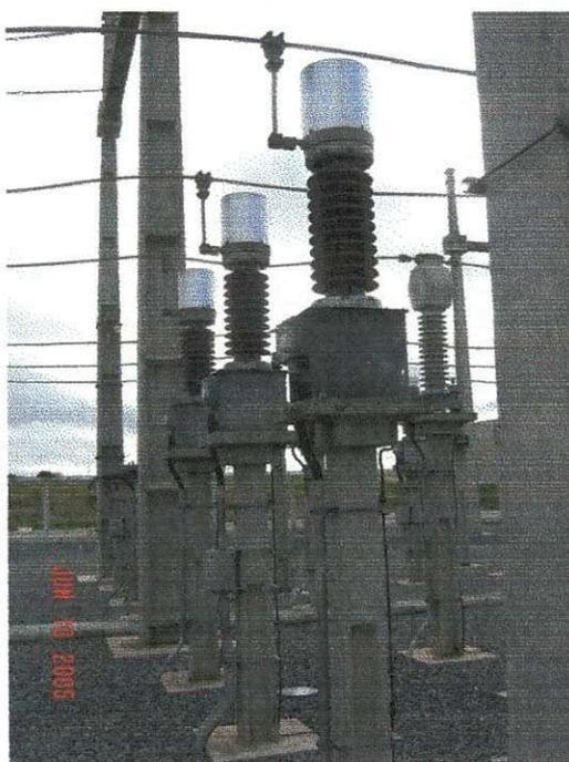
**Figura 07 – Transformadores de Potencial**
