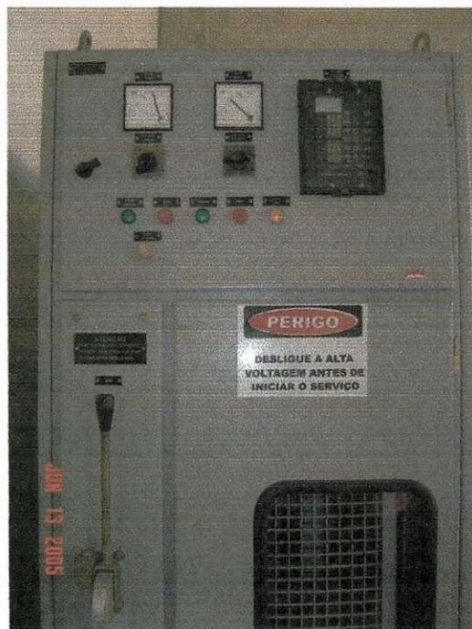
Figura 05 – Painel de Comando do Compressor
