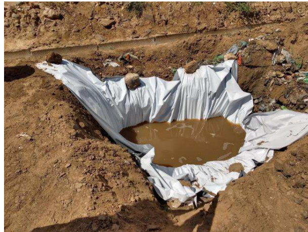
Figura 22: Cava preenchida até o nível de resíduos coletados.
