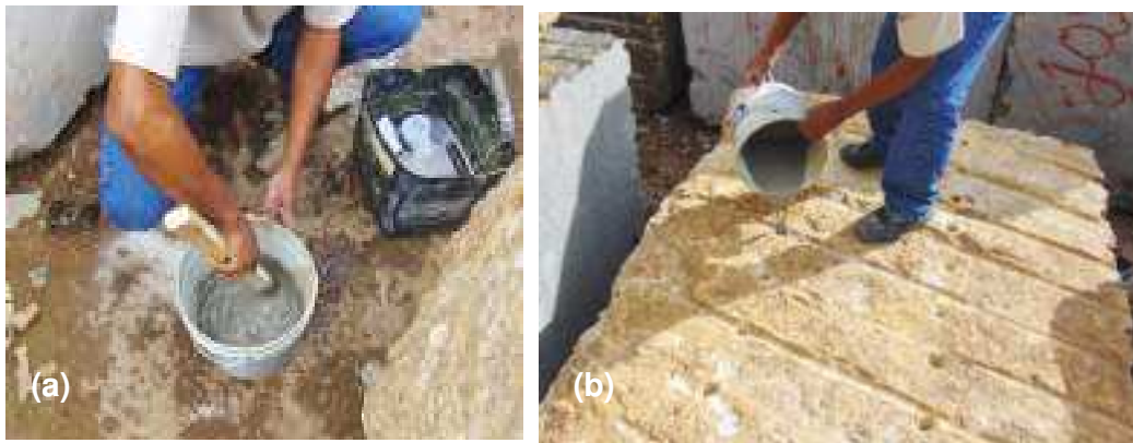
FIGURA 4.35 – Argamassa chinesa: (a) preparação da argamassa chinesa. (b) aplicação da argamassa chinesa.
