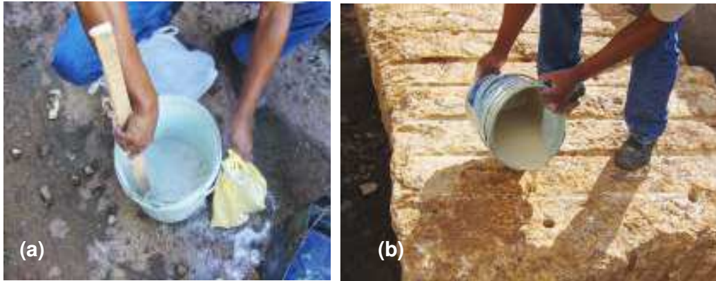
FIGURA 4.34 – Argamassa teste: (a) preparação da argamassa teste. (b) aplicação da argamassa teste.
