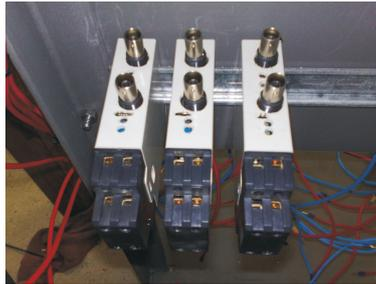
Figura 9: Sensores de Tensão e Corrente.
