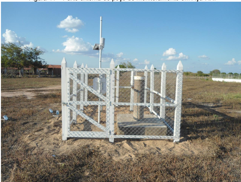
Figura 41 – Parte externa do poço de monitoramento em Açú-RN.
