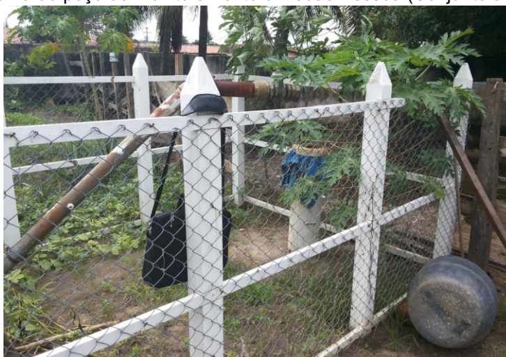
Figura 75- Parte externa do poço de monitoramento em João Pessoa (Conjunto José Vieira Diniz) - RN.
