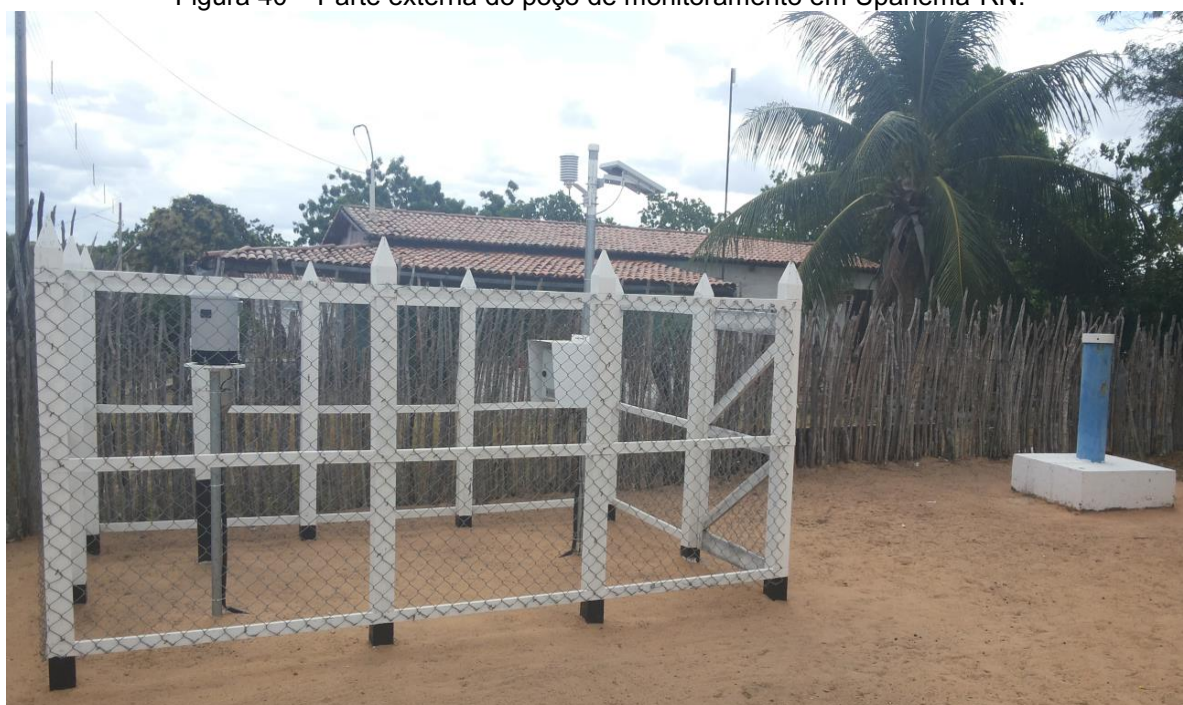
Figura 40 – Parte externa do poço de monitoramento em Upanema-RN.
