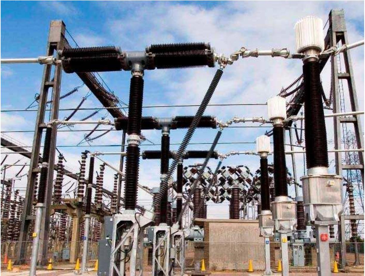
Fig. 3-12. Aplicação de um NXCT em subestação com tensão de operação de 420 kV. <sup>[10]</sup>
