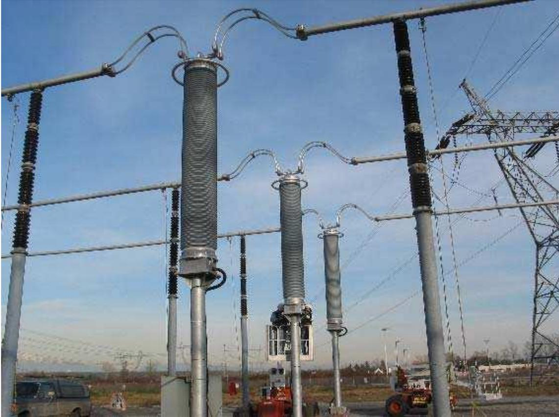
**Fig. 5.2. Aplicação do NXCVT numa linha de 550 kV. <sup>[9]</sup>**
