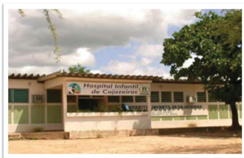
Figura 6 – Faixada do Hospital Infantil de Cajazeiras (HIC)
