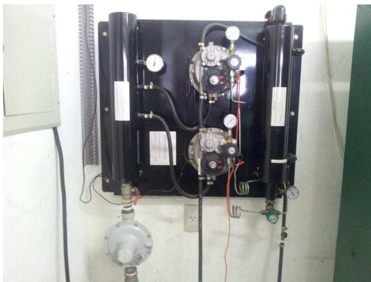
Figura 3.16 - Sistema de redução de pressão do GNV.
