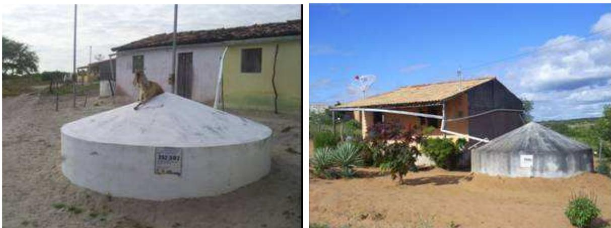
**Figura 8 e 9** Cisterna cilíndrica de placas pré-moldadas de cimento acoplada ao sistema de captação de água de chuva no Assentamento Cajueiro e Mocambo, respectivamente.
