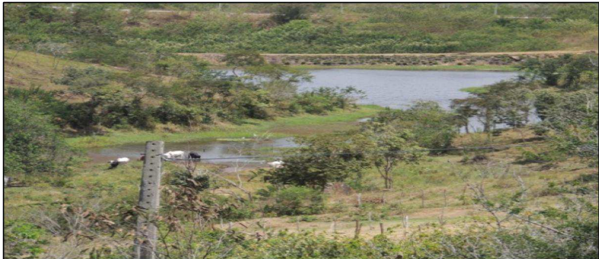
Figura 24. Barragem no Bairro das Nações.
