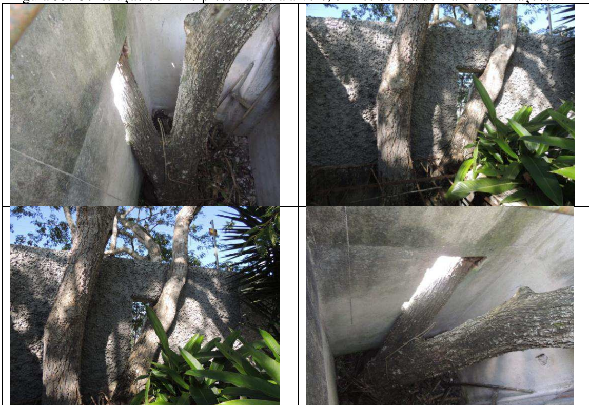
Figura 33. Construção de muro preservando a árvore, em residência do Bairro das Nações.
