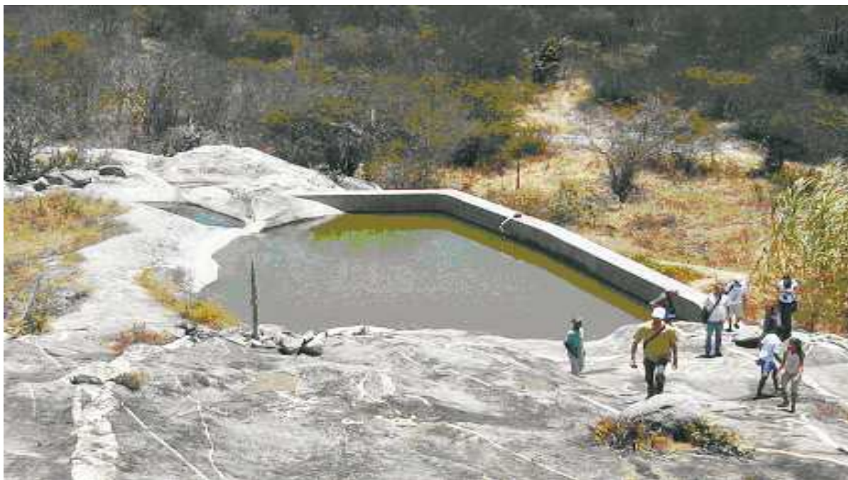
Figura 05 – Tanque de pedra
