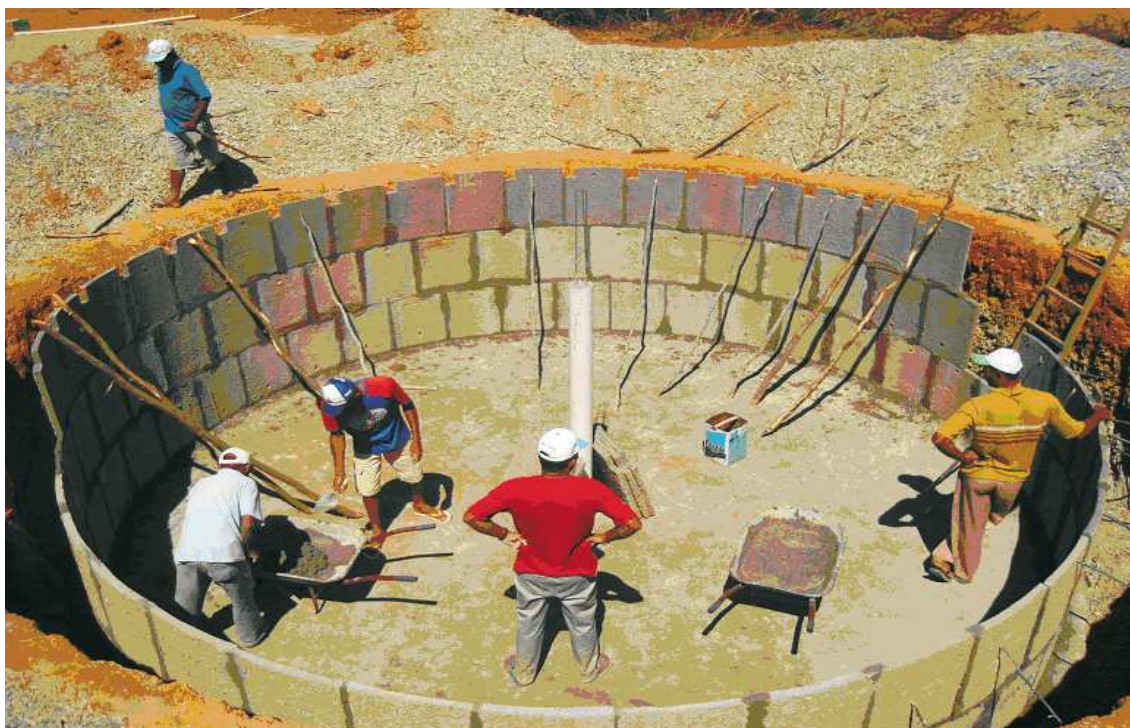
Figura 08 – Construção de cisterna para a produção de verduras e fruteiras
