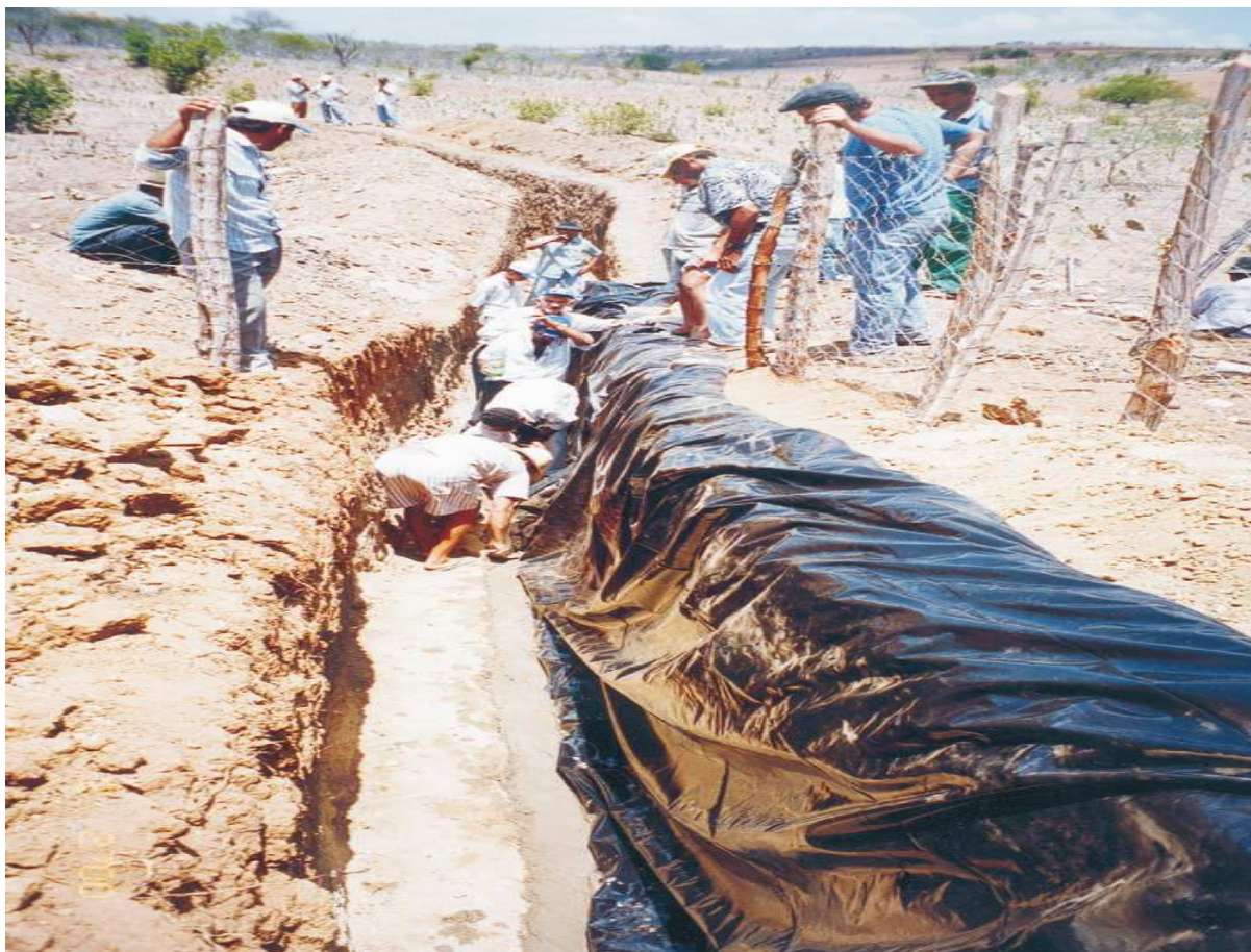
Figura 7 – Barragem subterrânea, colocando a lona de PVC
