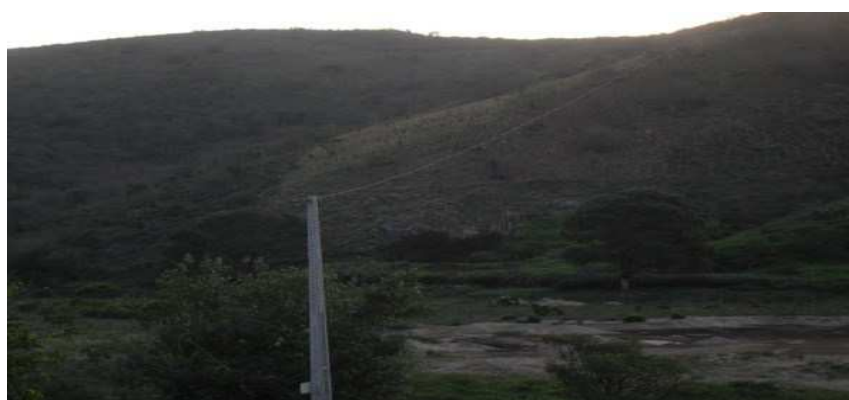
Figura 15. Visualização das paredes da barragem
