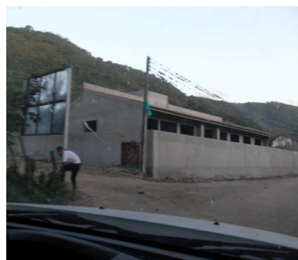
Figura 07. Construção do posto de saúde
