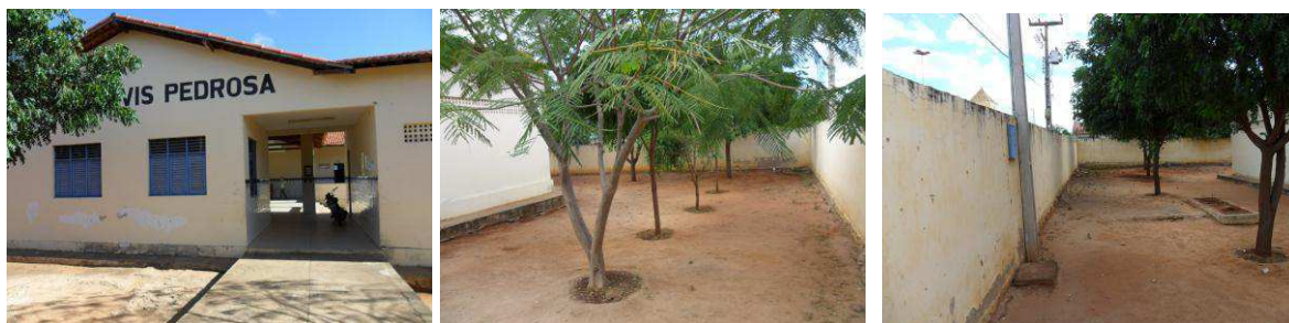
Figuras 02, 03 e 04: Fachada da escola, lateral direita e lateral esquerda da entrada.
