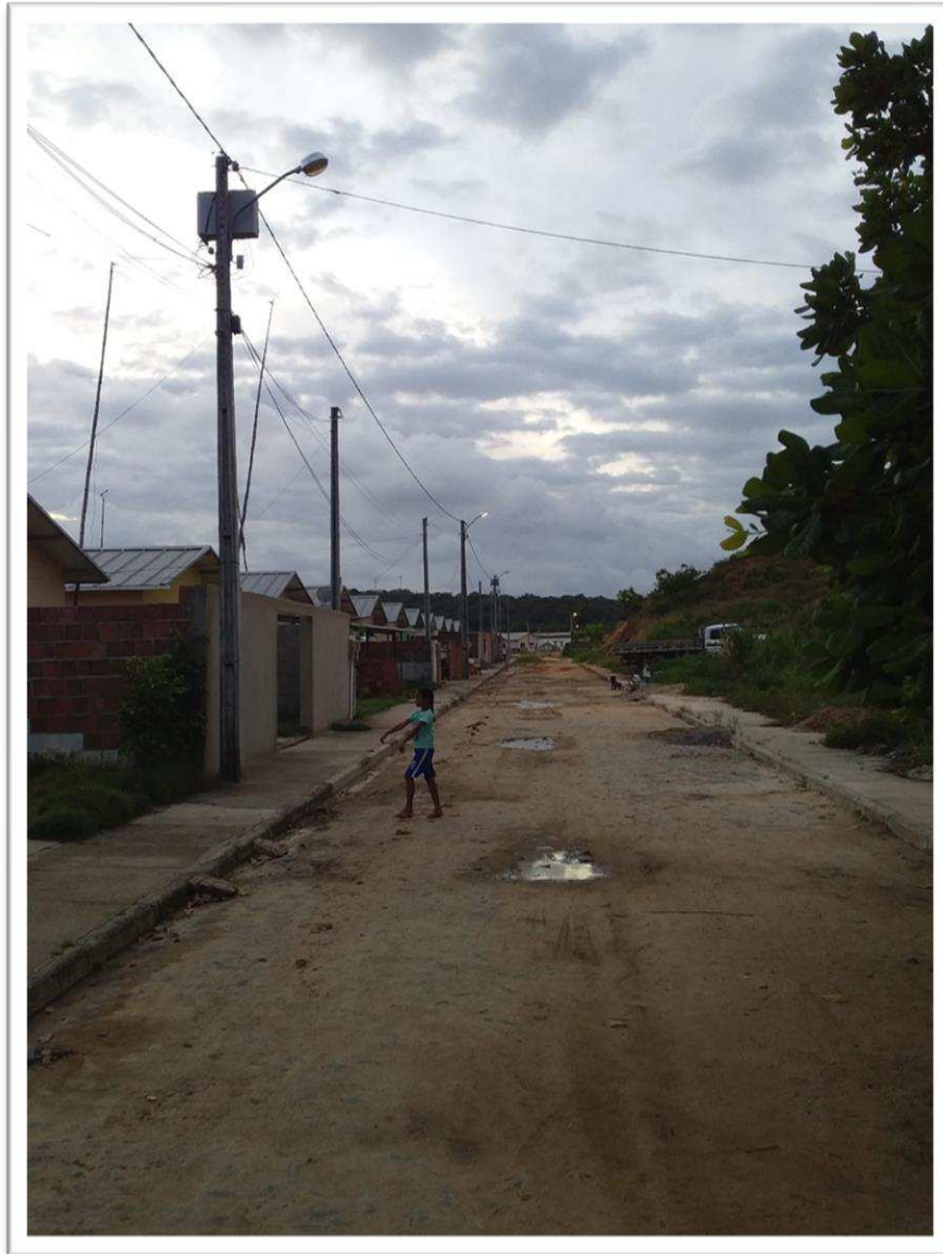
FIGURA 14 – RUA INCONCLUSA DE NOVA TATUOCA
