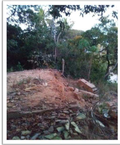
FIGURA 11 – CASA DEMOLIDA EM CALHETAS
