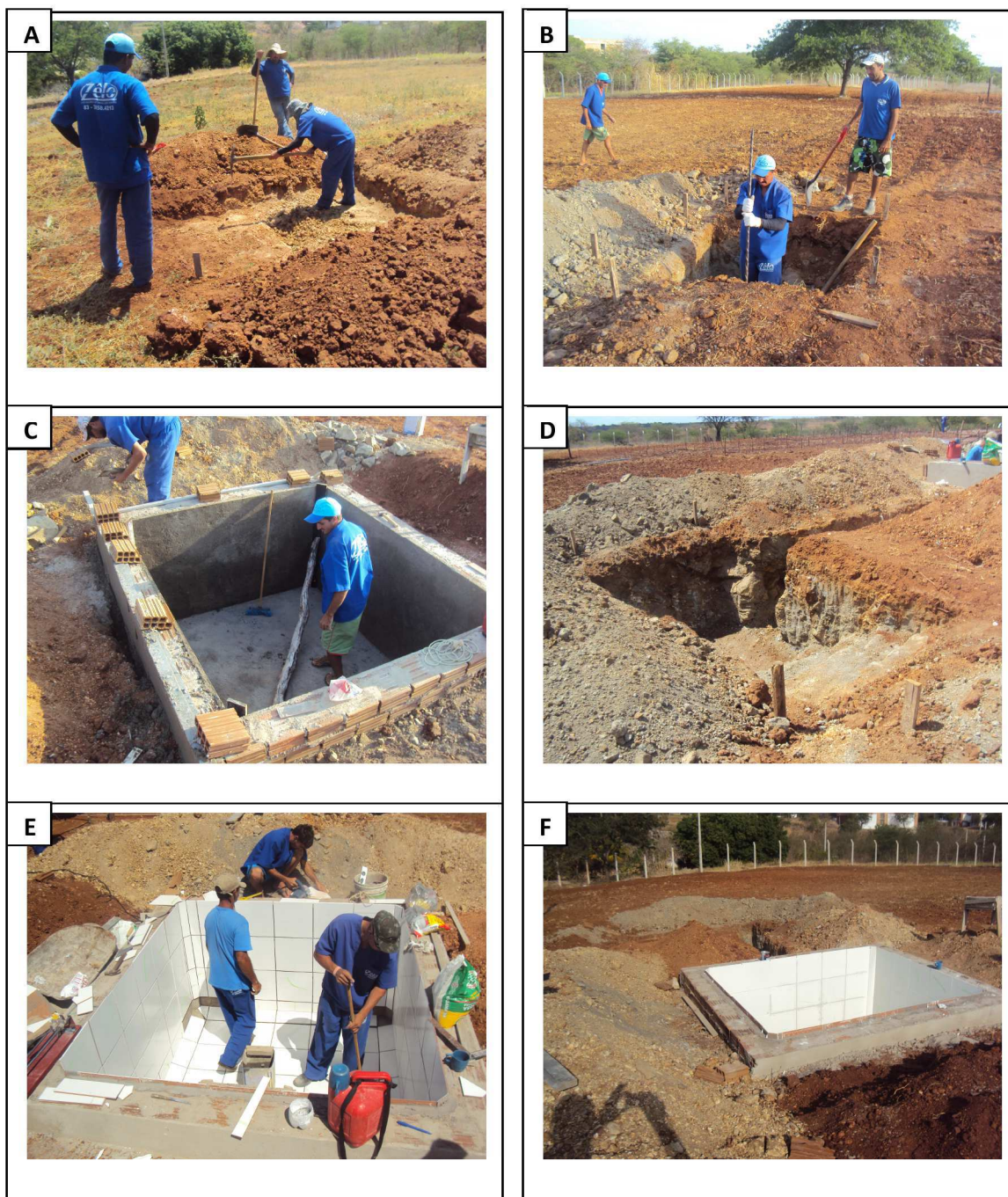
Fotos A 3. Escavação do lisímetro com separação das camadas do solo para posterior preenchimento do mesmo (A) e (B); Execução do tanque em alvenaria que irá compor o lisímetro (C); Escavação do poço de coleta da água de drenagem e da vala do dreno do lisímetro(D); Impermeabilização cerâmica das paredes e fundo do lisímetro (E) e (F).
