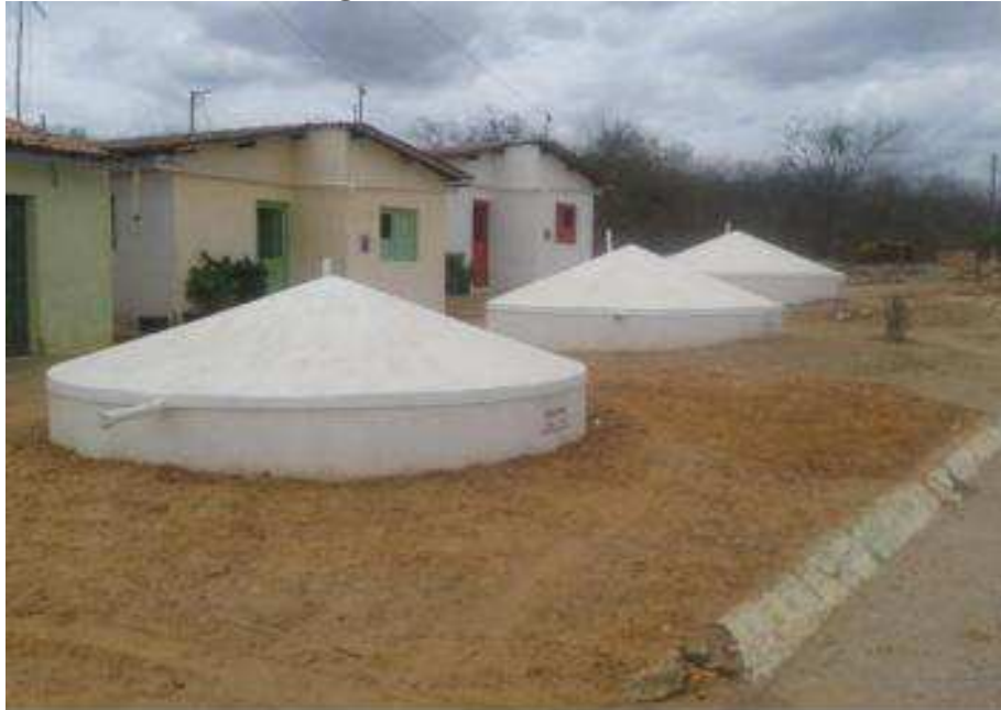
Figura 1 - Cisterna de Placa
