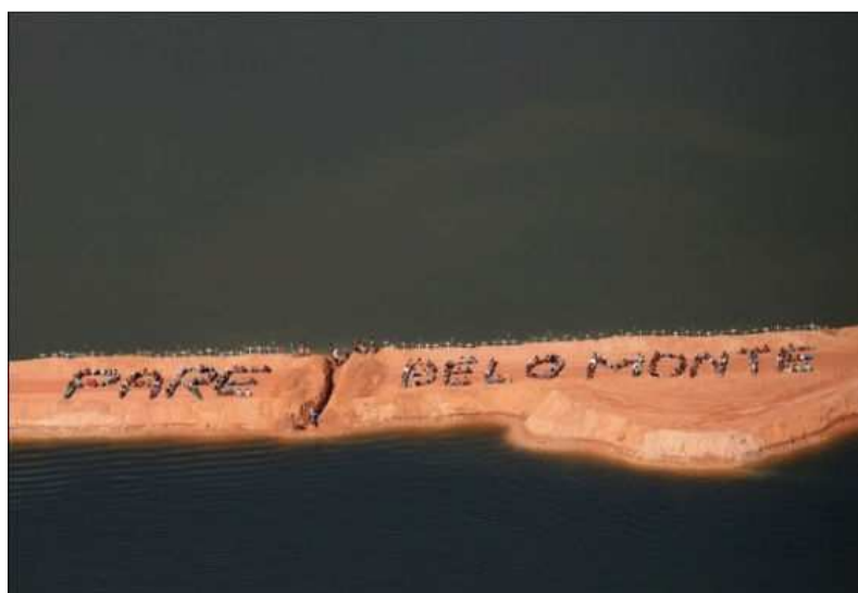
Figura 47 - Ocupação do Canteiro Belo Monte (2012)
