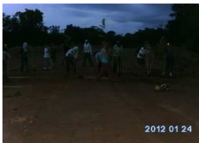
Figura 41 - Ocupação do Canteiro Belo Monte (2012)
