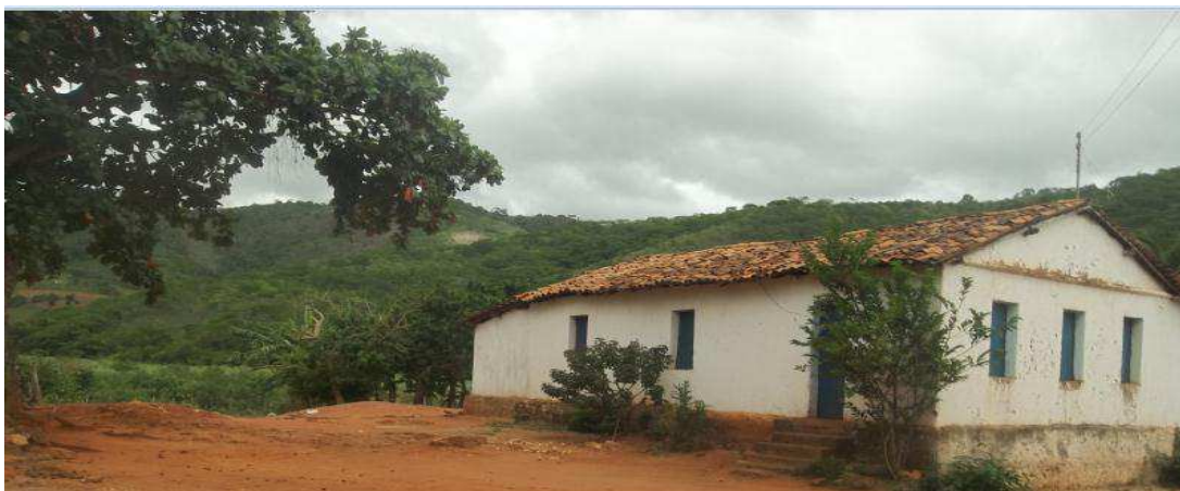
Figura 4 - Casa onde funcionava o Engenho de Mininéia Coelho Vianna.
