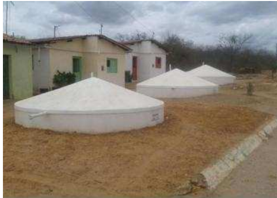
Figura 4 – Cisterna de placa
