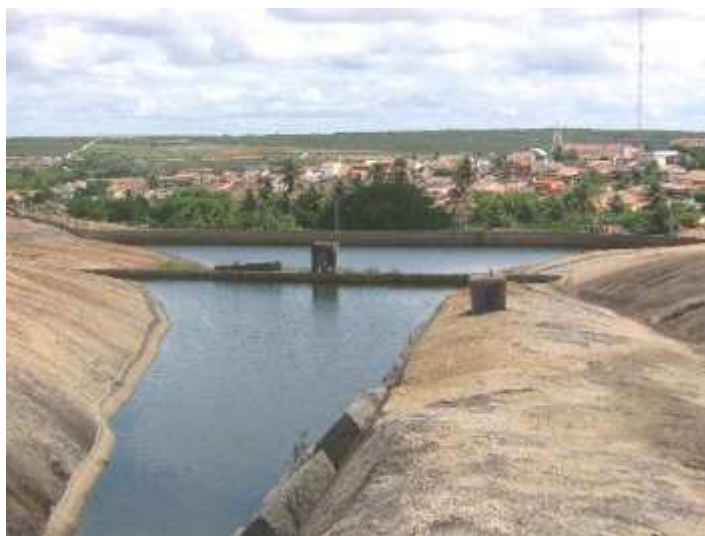
Figura 5 – Tanque de pedra localizado no município de Pocinhos - PB
