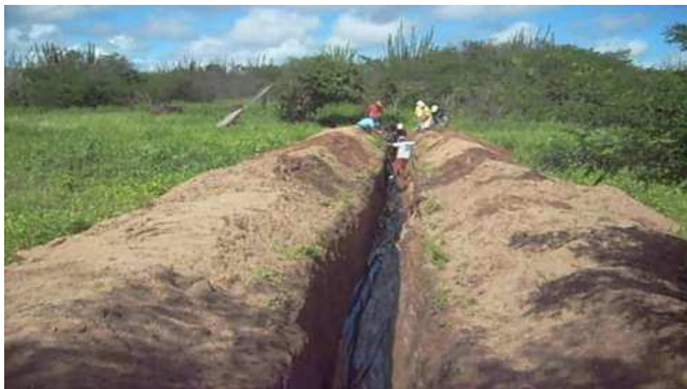
Figura 2 – Construção de barragem subterrânea
