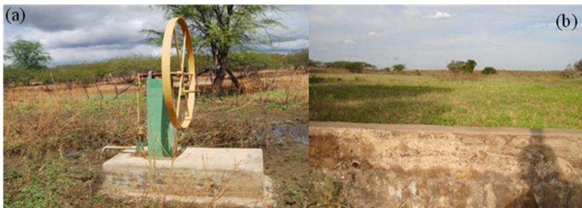
Figura 43: Tecnologias adaptadas ao semiárido: (a): bomba d'água popular, instalada em poço artesiano na comunidade Câimbra, município de Cacimba de Areia; (b): barragem subterrânea, construída na comunidade Cachoeira, município de Cacimba de Areia.
