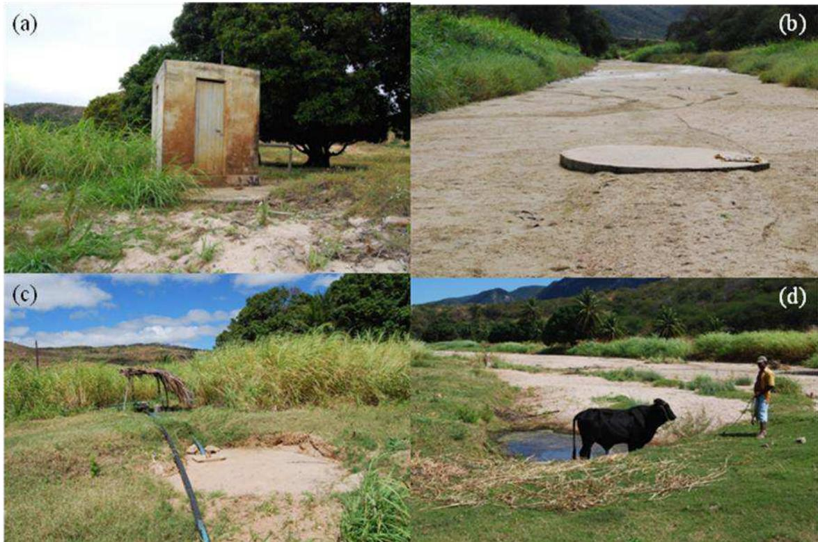
Figura 20: Poços construídos às margens ou no leito de riacho e rio principal: (a) – Poço que abastece a cidade de Salgadinho, no Riacho Macambira; (b) – poço amazonas na comunidade Pedrecal; (c) – poço amazonas que abastece o povoado de Serraria, município de Salgadinho; (d) – cacimba perfurada no leito do rio, para abastecimento dessedentação animal (Povoado de Serraria, município de Salgadinho).
