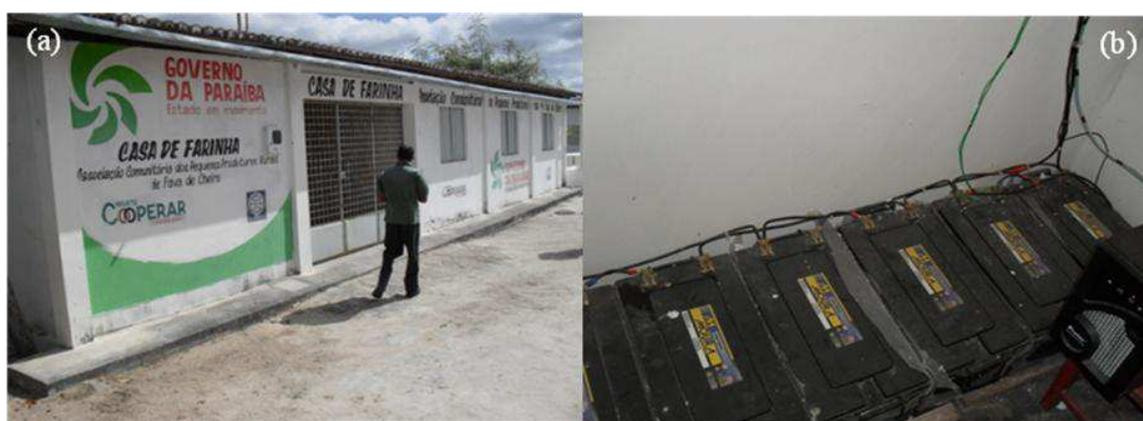
Figura 45: Unidades de beneficiamento em Fava de Cheiro: (a): casa de farinha; (b): interior da unidade de beneficiamento de frutas, em destaque as baterias para armazenamento de energia solar.
