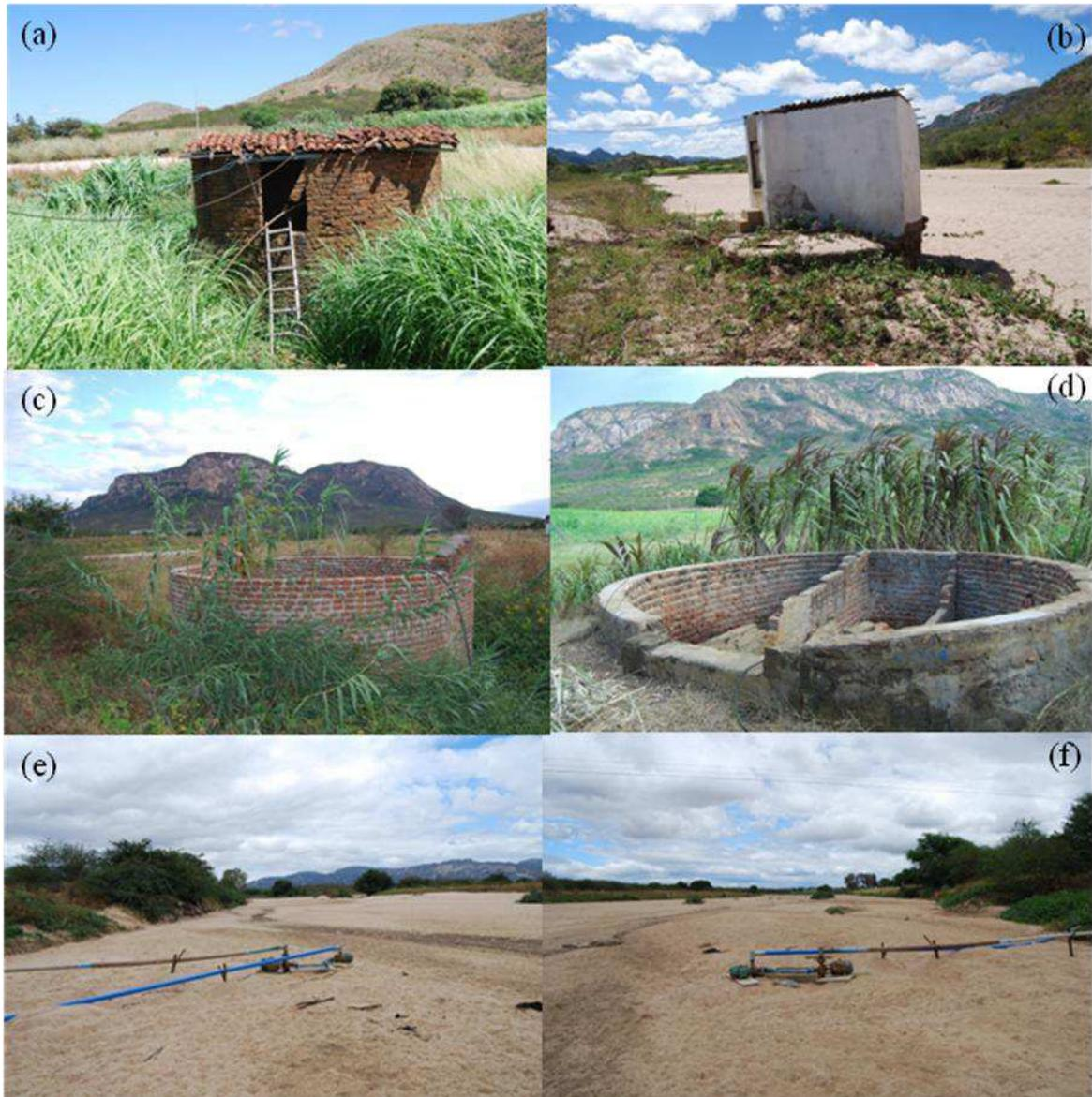
Figura 21: Poços construídos às margens ou no leito do Rio Farinha para abastecimento de cidades e povoados: (a) – poço que abastece o povoado de Rampa, município de Areia de Baraúnas; (b) – poço que abastece a cidade de Areia de Baraúnas; (c) – poço amazonas que abastece a cidade de Passagem; (d) – poço que abastece o povoado de Café do Vento, município de Passagem; (e) e (f) – poço que abastece a cidade de Cacimba de Areia.
