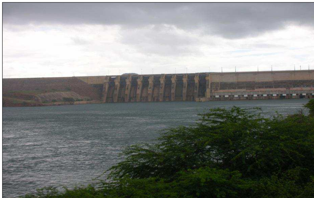
Imagem 4 – Usina Hidrelétrica Luiz Gonzaga
