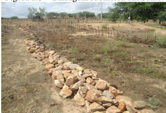
Segundo Vieira (2002), as barragens submersas consistem de um septo construído no depósito aluvial de rios e riachos com finalidade de impedir que a água infiltrada no depósito aluvial continue escoando durante a estiagem até se exaurir. A barragem retém o fluxo facilitando a captação e beneficiando comunidades próximas. Esta forma de armazenamento também objetiva reduzir os efeitos da evaporação.
