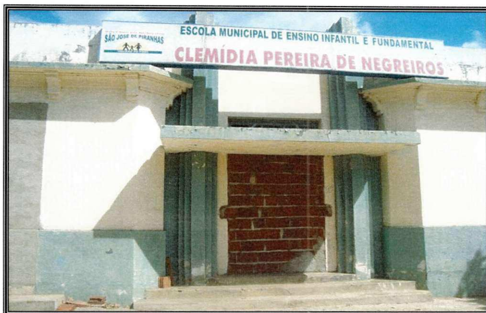
Figura 05 - Antigo Correio municipal da cidade de São José de Piranhas, hoje funciona as Instalações da Escola Clemídia pereira de Negreiros.
