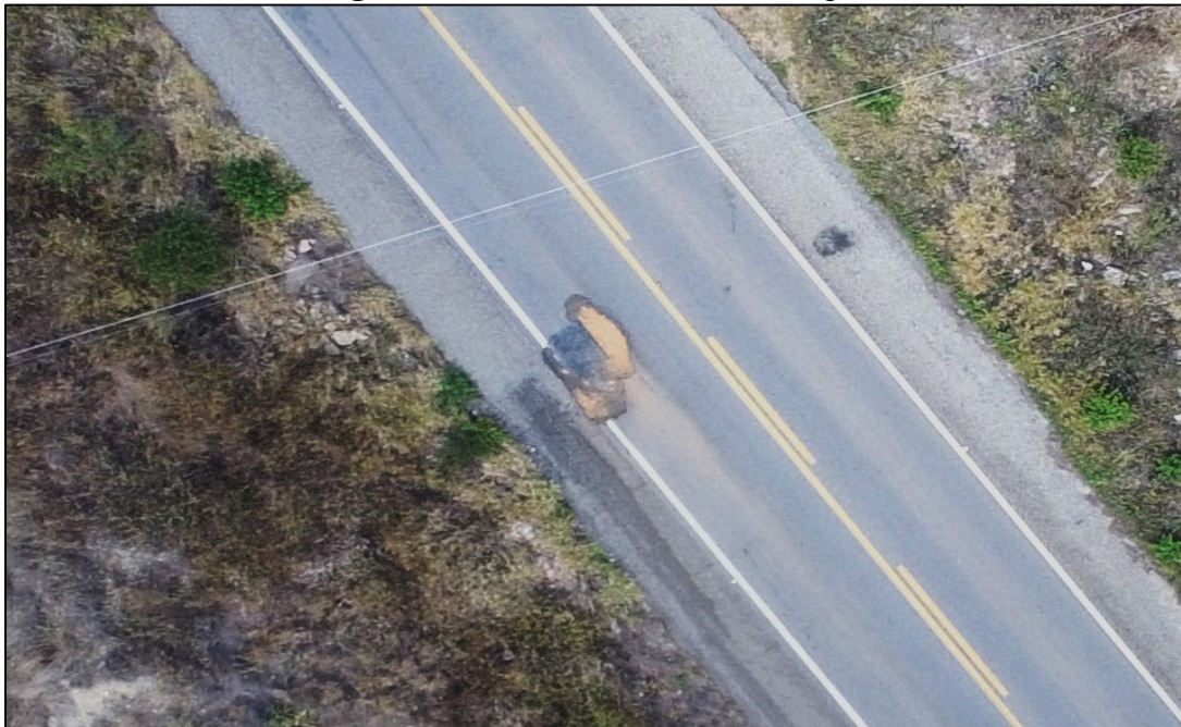
Figura 6 - Panela ou buraco br-412/pb.
