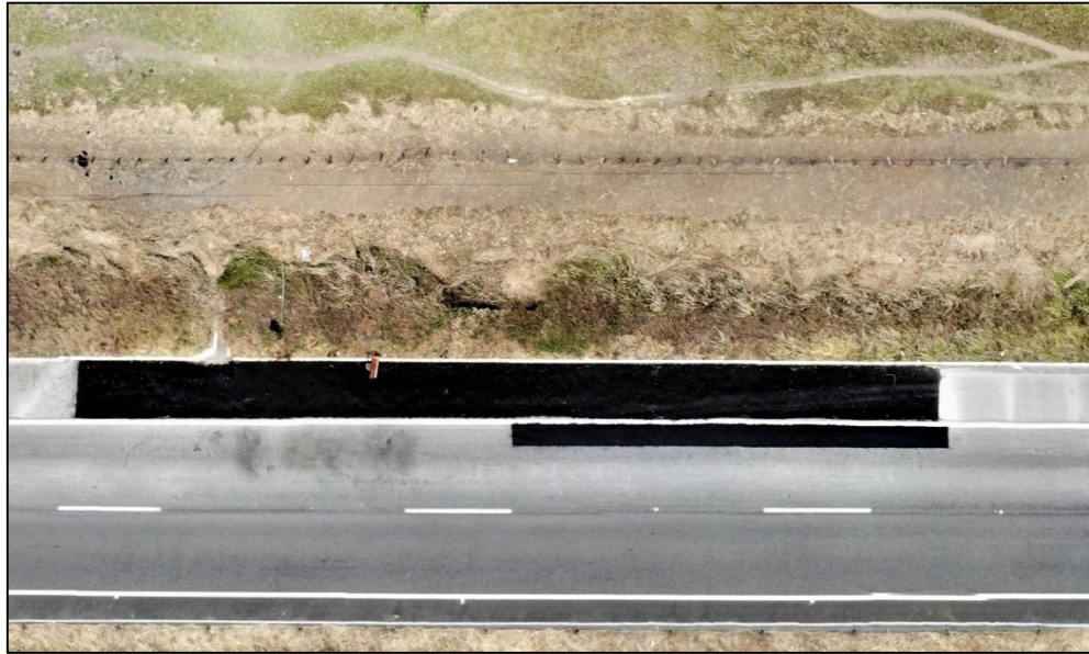
Figura 7 - Remendo br-230/pb.
