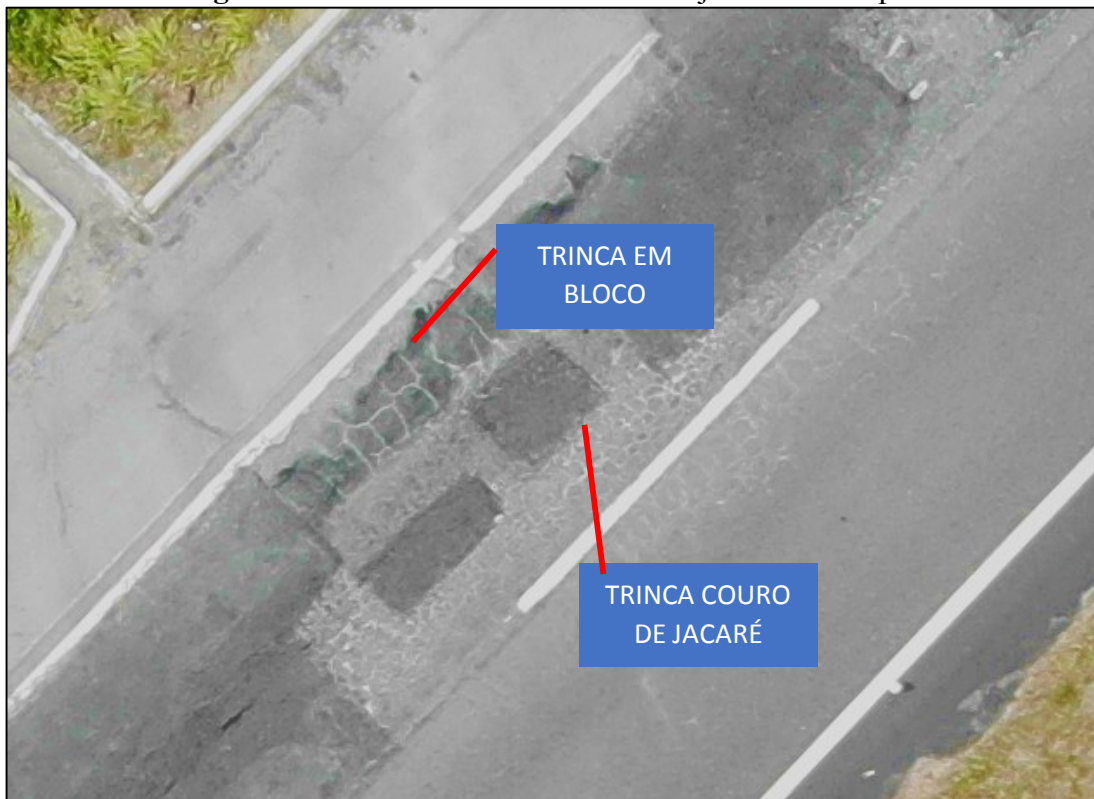
Figura 4 - Trincas em bloco e couro de jacaré br-230/pb.
