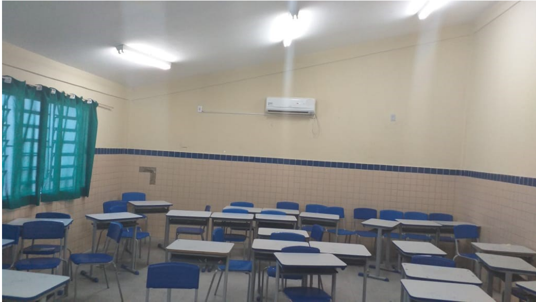
Foto 3 - Sala da aula com teto em laje inclinada
