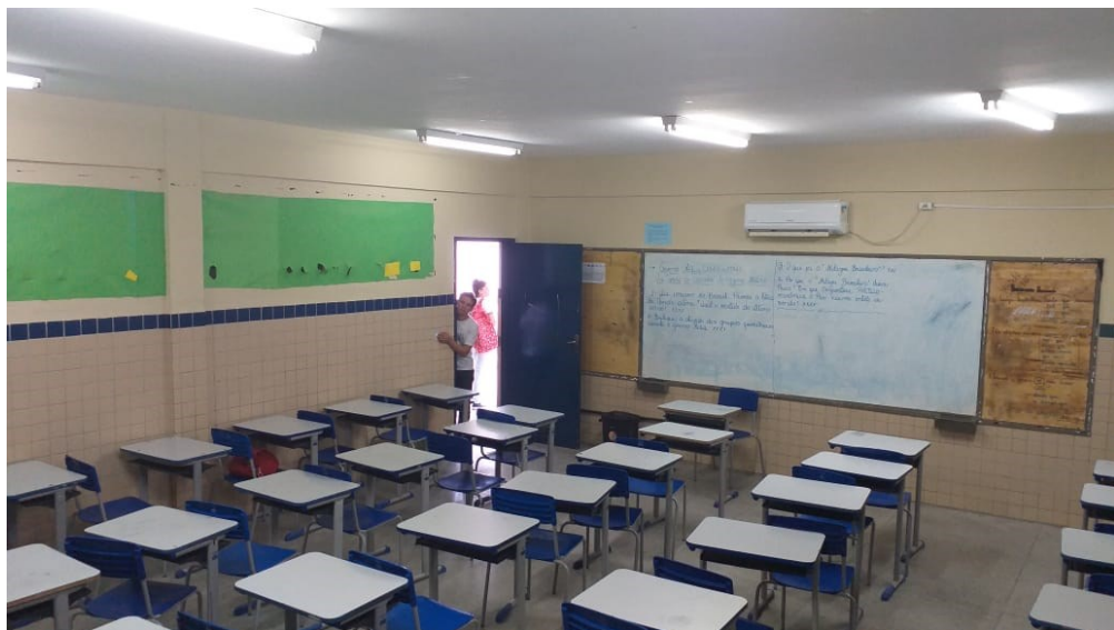
Foto 4 - Sala da aula com forro PVC no teto
