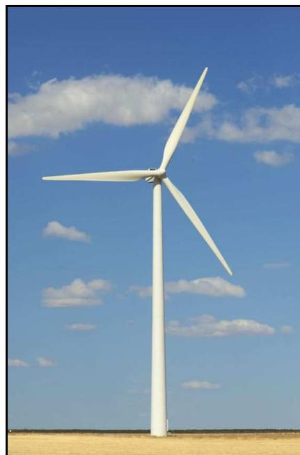
Os aerogeradores mais modernos, com eixo vertical, contam com sofisticados princípios aerodinâmicos para produção de eletricidade e possuem rotores de eixo horizontal com três pás acopladas a ele (Dutra, 2008). Por serem os mais usados atualmente, será o tipo de aerogerador abordado no decorrer deste trabalho.
