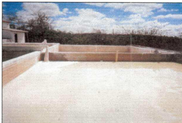
Figura 2.2 – Tanques de decantação para lavagem do caulim - CAULISA - SA, Br 230 - PB, km 250
