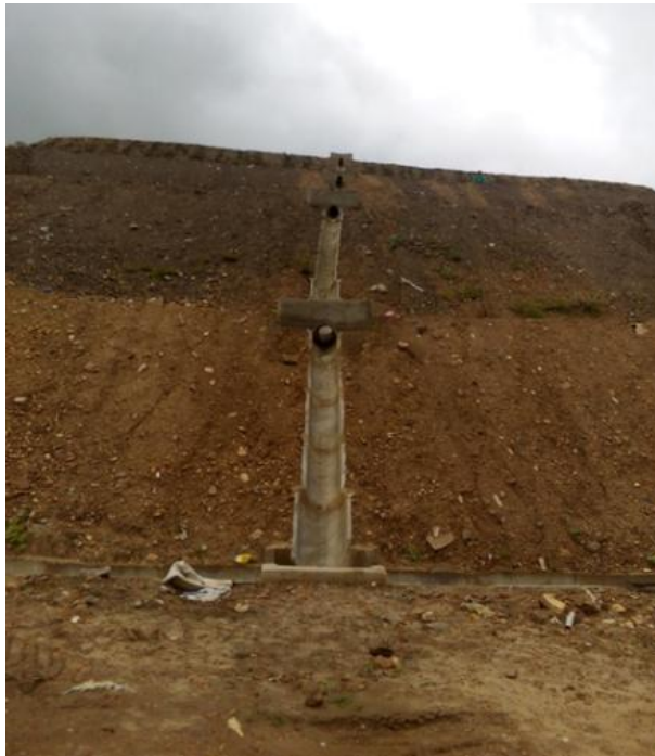
Figura 5: Dreno de água.
