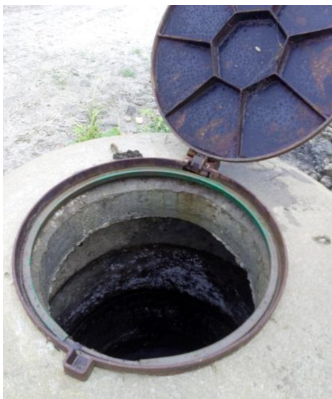
Figura 6: Reservatório da massa do chorume do Aterro Sanitário EcoSolo.
