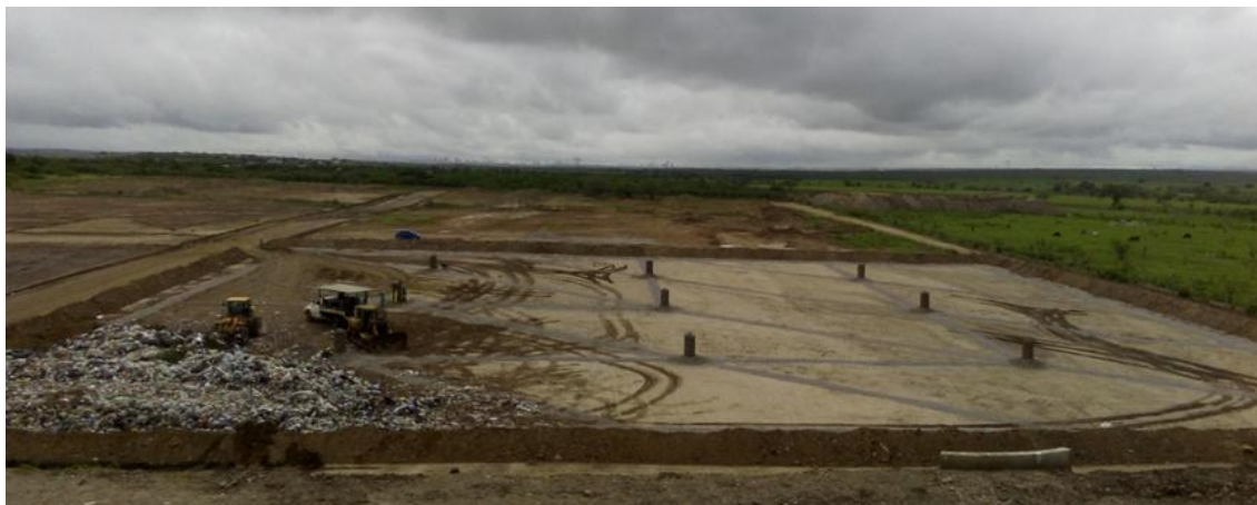
Figura 2: Preparação de uma nova célula no Aterro Sanitário EcoSolo.
