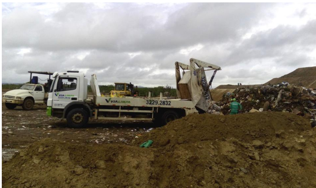
Figura 8: Resíduos sendo despejados na célula por um caminhão de caixa estacionária.
