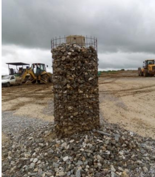
Figura 4: Construção do dreno de chorume.
