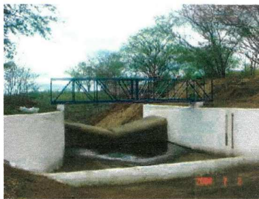
Figura 4.6 Vertedor da Sub-Bacia 1
