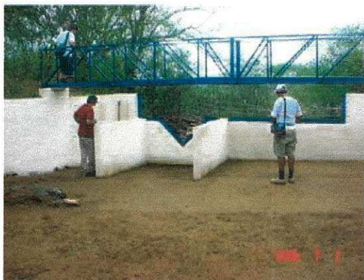
Figura 4.7 Vertedor da Sub-Bacia 2
