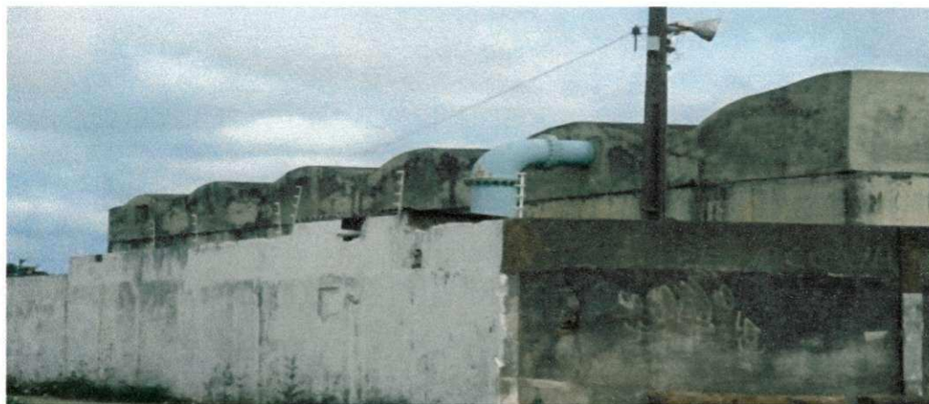
Figura 4.1 – Reservatório de distribuição de água R-9.
