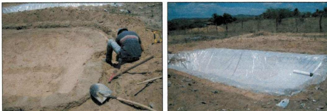
**Figura 6.** Impermeabilização das lagoas de estabilização. Ibimirim-PE, 2010.
