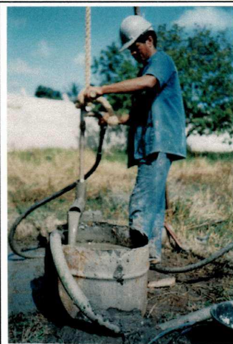
Figura 3.18 - Perfuração por simples lavagem com trépano e uso de lama bentonítica.
