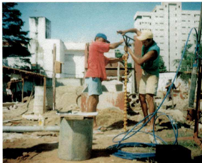
Figura 3.19 - Perfuração simples com uso de trado manual.
