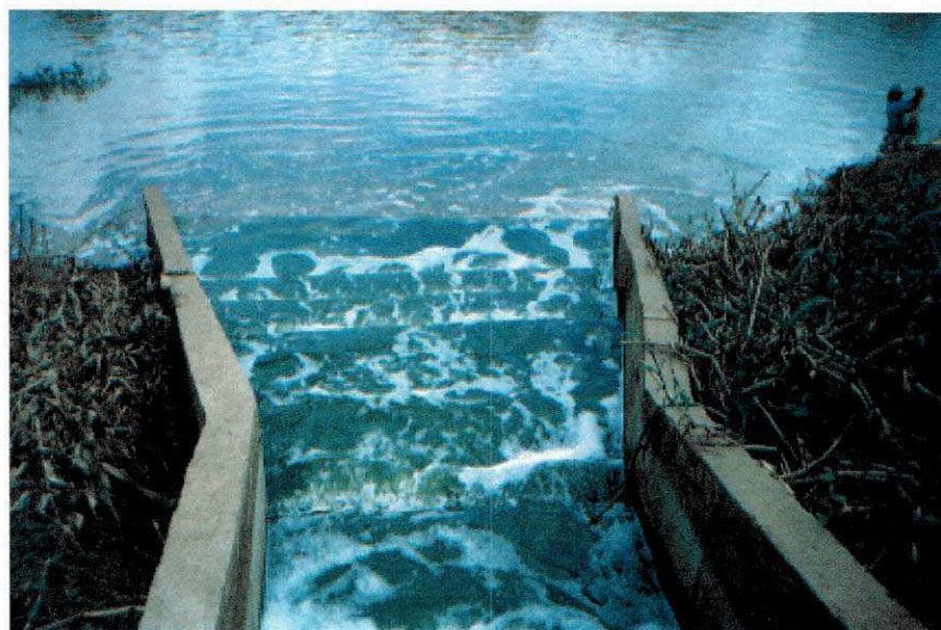
Figura 3.10 - Descarga em forma de cascata do efluente final no corpo receptor, o Rio Poty - Teresina (PI)
