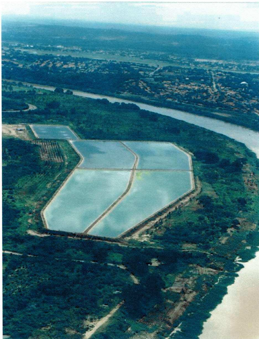
Figura 3.3 - Vista aérea do sistema de lagoas de estabilização da ETE Leste - Teresina (PI)
