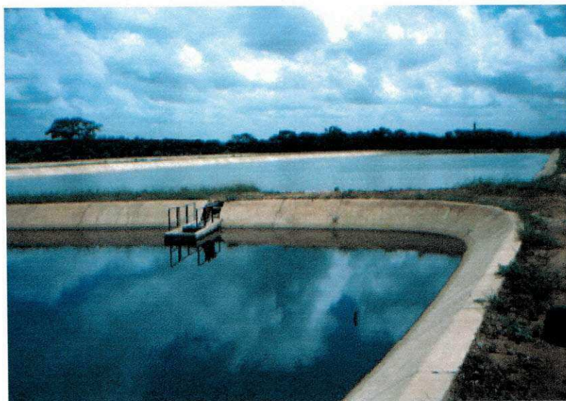
Figura 3.8 - Vista da transposição da segunda para a terceira lagoa de maturação com dispositivo vertedouro
