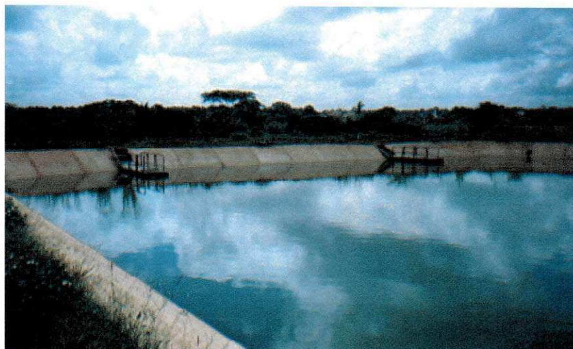
Figura 3.9 - Dispositivos de saída da lagoa de maturação
