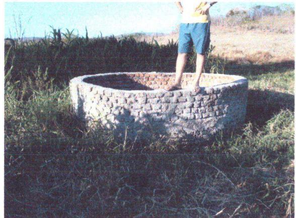
Poço amazonas como reserva de água
