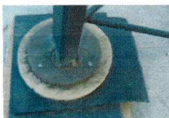
Figura 37. Instalação das células de pressão
