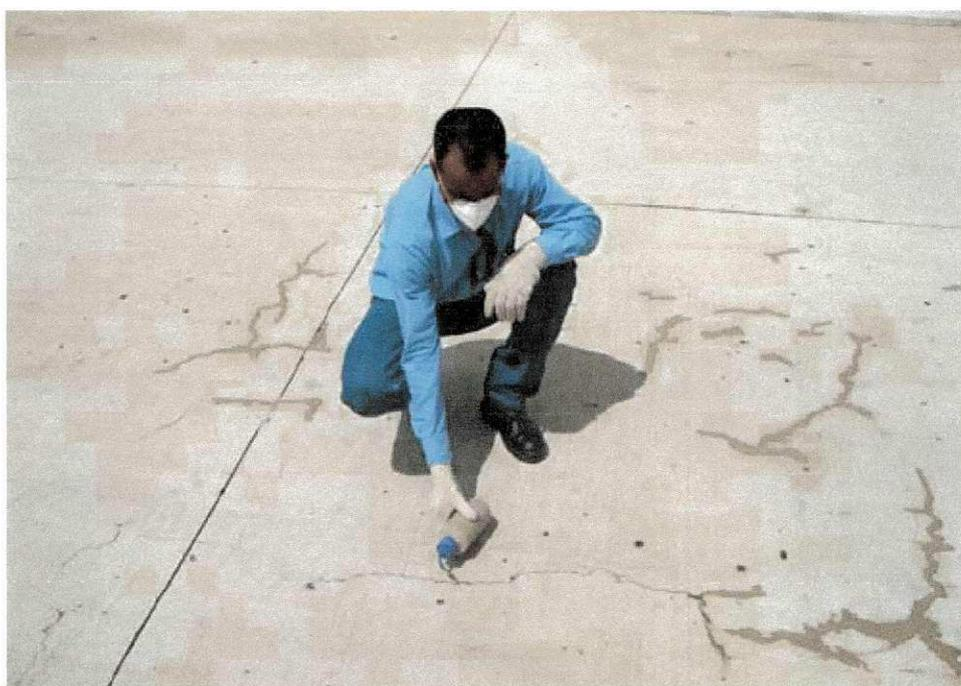
Figura 2.23 – Preenchimento das fissuras através da injeção por gravidade (Picetes) utilizando calda coloidal de microcimento.
