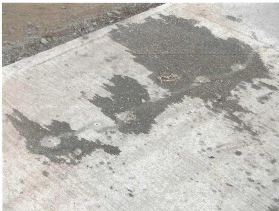
Figura 2.12 - Resultado da aplicação da resina epoxídica.
