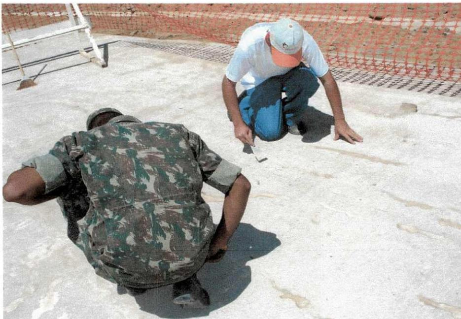
Figura 2.24 – Remoção e limpeza do excesso de calda coloidal sobre a fissura.
