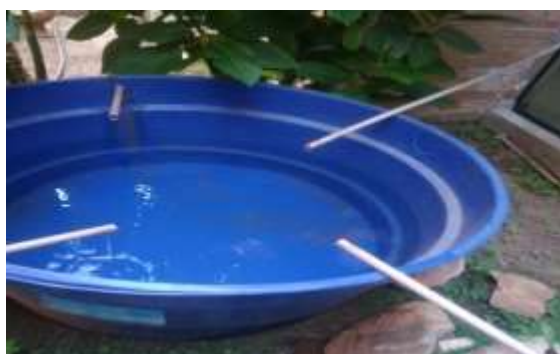
Figura 16a – Reaproveitamento da água do ar condicionado
