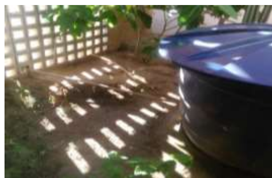
Figura 16b – Reaproveitamento da água do ar condicionado
