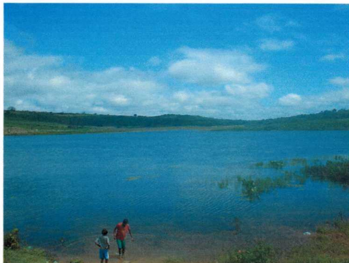
Figura 4: Vista do açude localizado na Aldeia Sede
