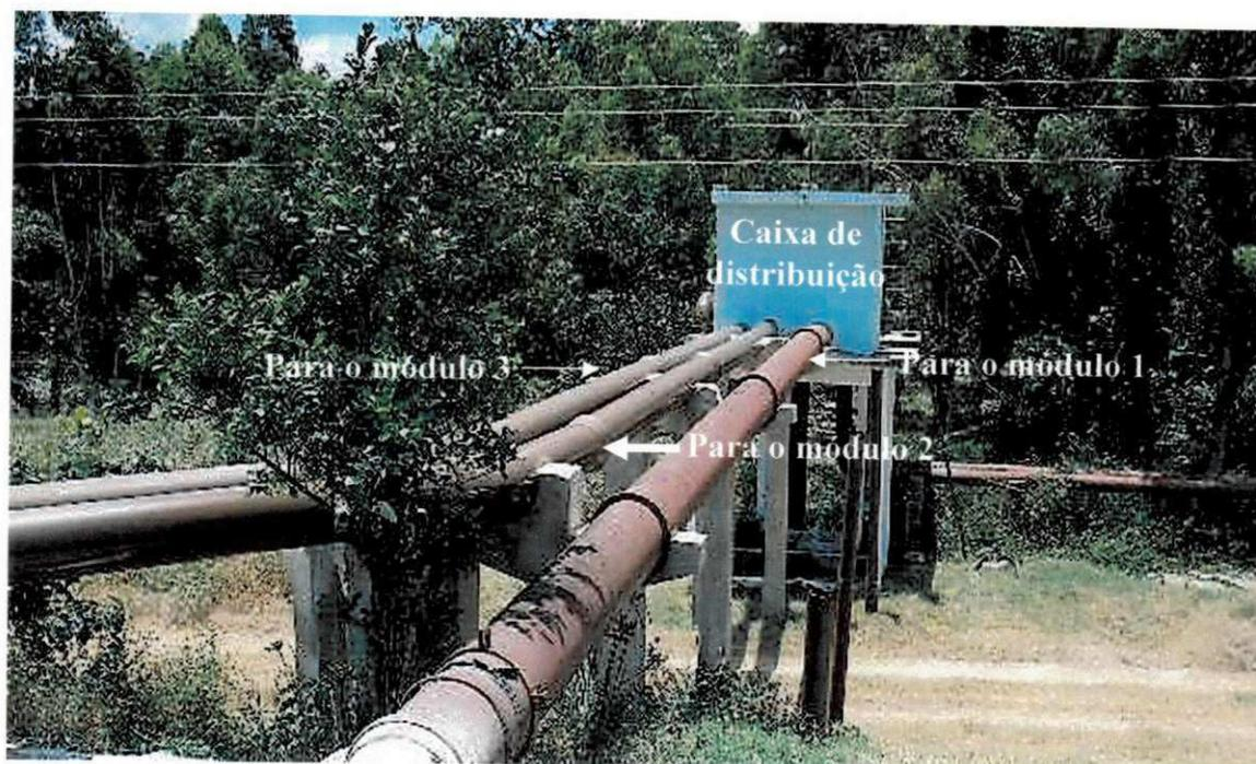
**Figura 3.5** – Caixa de distribuição de esgotos.
