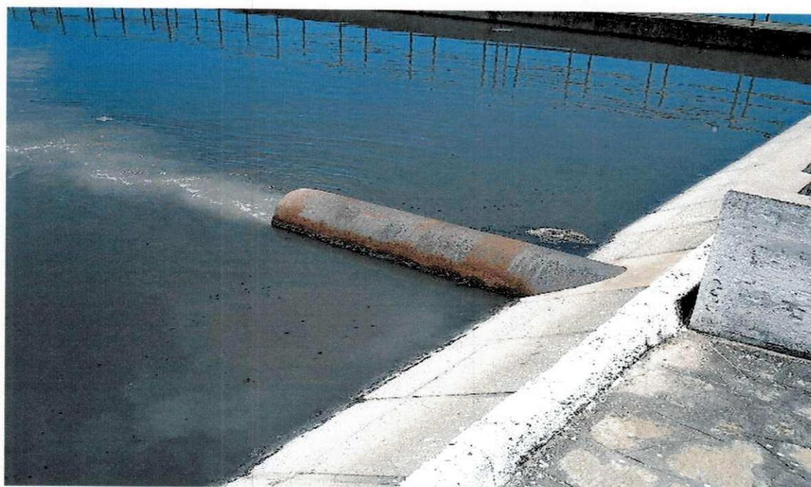
**Figura 3.6** – Dispositivo de entrada da primeira lagoa anaeróbia.
